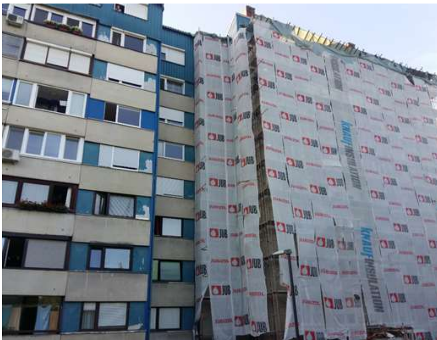
Slika 5: Primer energetske prenov le enega dela več-stanovanjske stavbe
