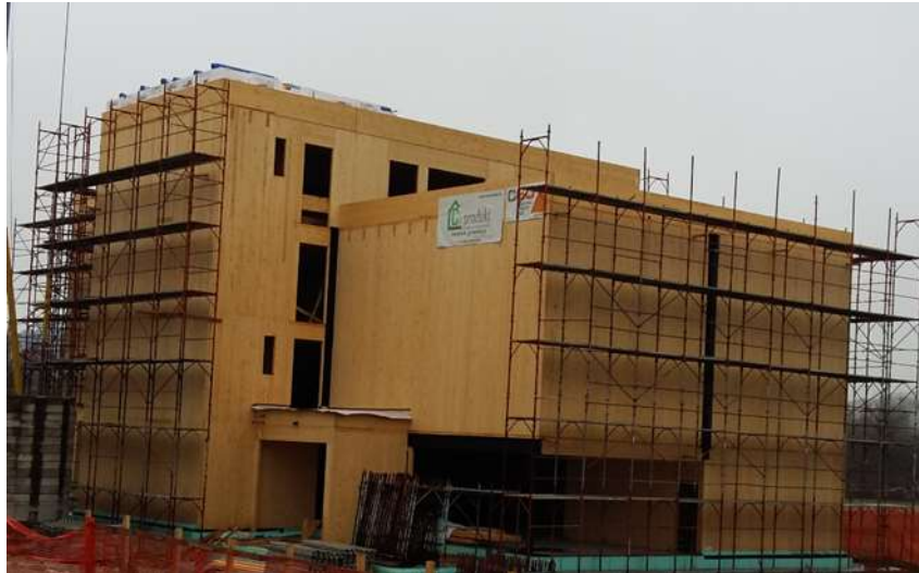
Slika 12: Primer izgradnje Squash dvorane z lesom, kot osnovnim gradbenim materialom
