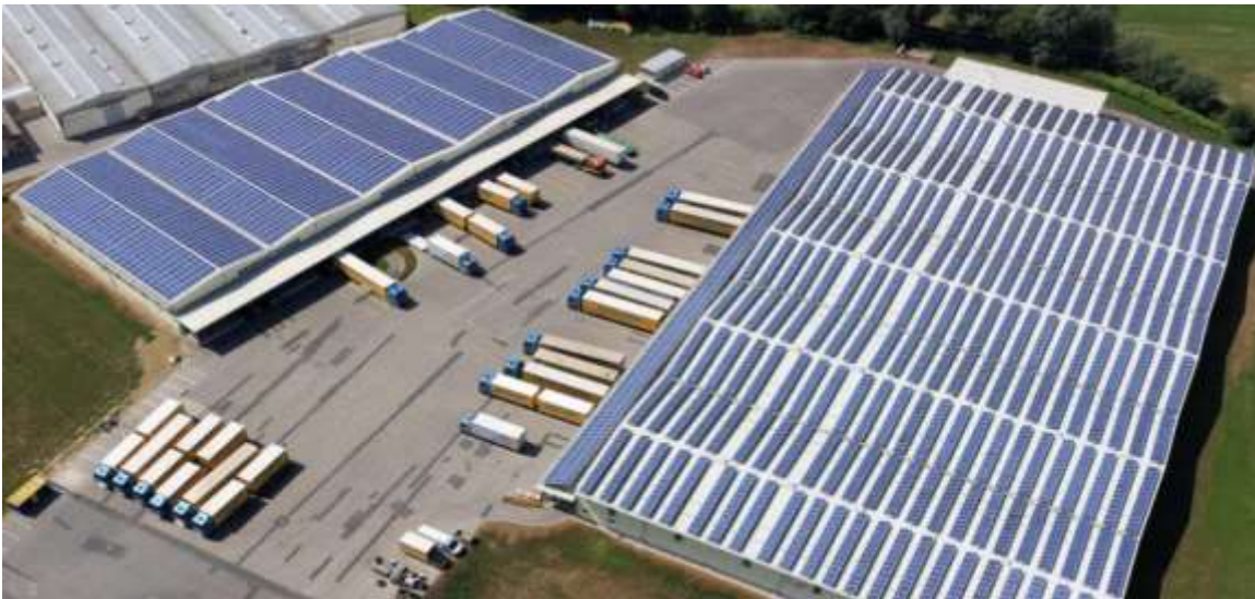
Slika 11: Primer dobre in ne-optimalne integracije PV sončnih modulov na strehe stavb
