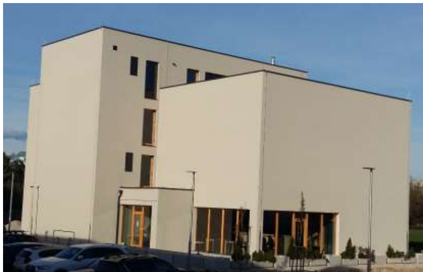
Slika 13: Fasada Squash dvorane je bila nato še izolirana in obdana s standardno fasado
