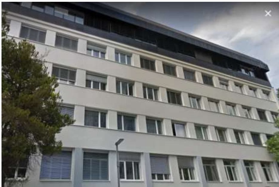
Slika 4: Tudi stavba ELES in EIMV npr. potrebuje energetske prenovi
