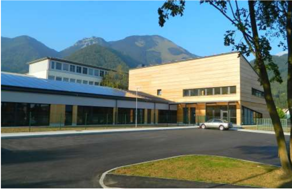
Slika 3: Integracija PV sončnih modulov na otroški vrtec v Preddvoru
